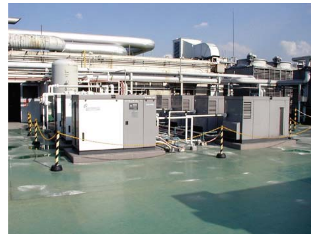
印刷工場 (屋上設置) SMS37SD×7台
