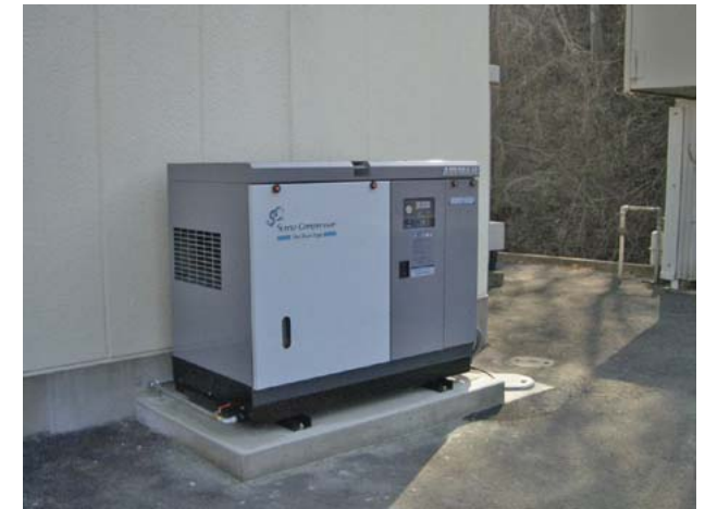
製造工場 SMS15SD×1台
