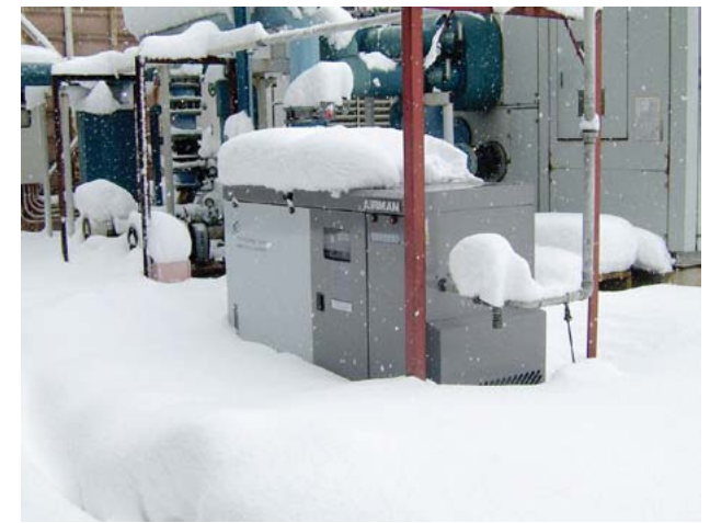
製造工場 SMS22SD×1台
