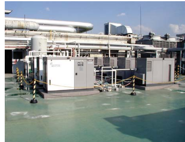
印刷工場(屋上設置) SMS37SD×7台
