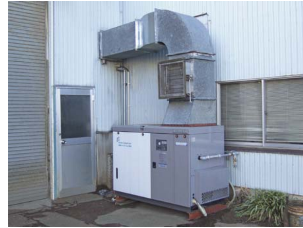
鋳造工場(排熱利用) SMS22SD×1台
