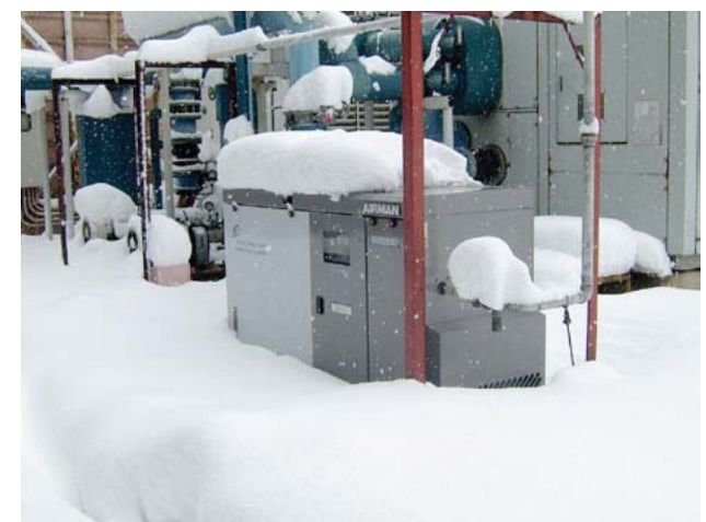
製造工場 SMS22SD×1台
