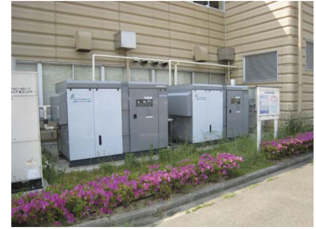
製造工場 SMS55SD×2台
